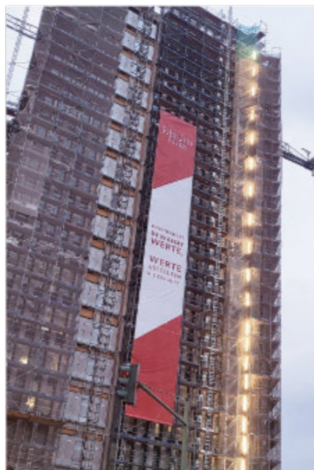
John Jahr-Werbeplakat an der Rohbau-Fassade
