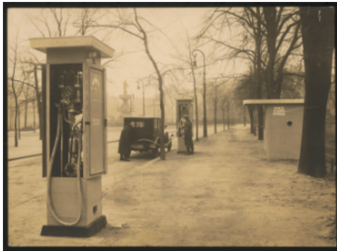
Tankstelle der Reichskraftsprit GmbH, Berlin, Archiv der TU Berlin F 16800
