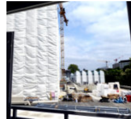
Die Baustelle vom Infocenter aus betrachtet
