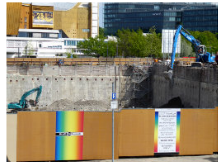
Blick in die Baugrube
