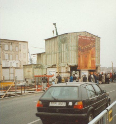
Während des Verschiebeprozesses
