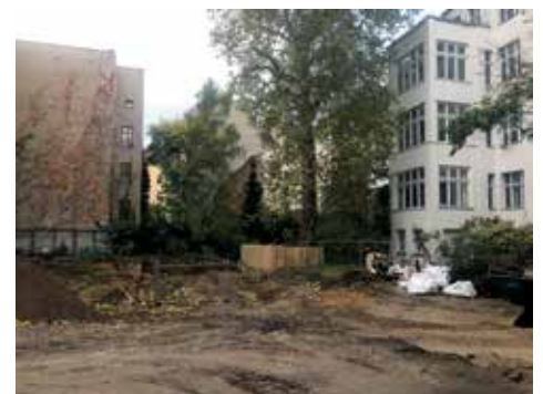
Die Baugrube in der Potsdamer 68
