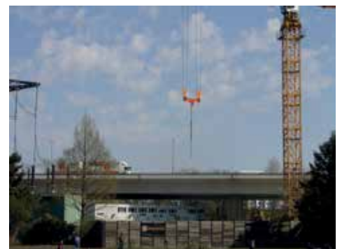
Bau des Kabeltunnels an der Rudolf-Wissell-Brücke
