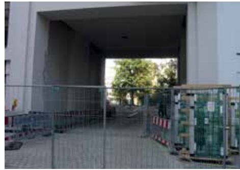
Der Fußgängerweg durch Schönegarten von der Kurfürsten- zur Kluckstr. ist noch nicht fertig
