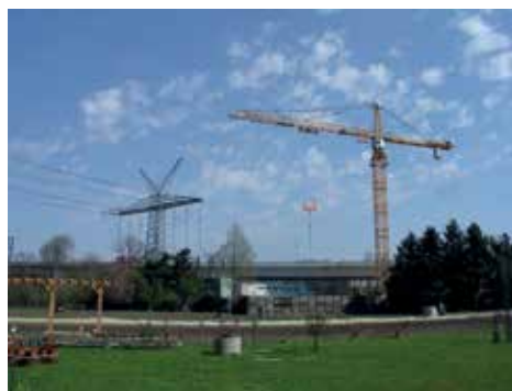
Ende der Hochspannungsleitung an der Rudolf-Wissell-Brücke
