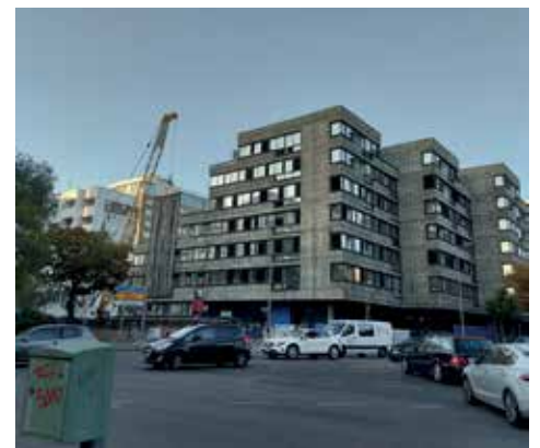
Abriss des Constanze-Pressehauses Kurfürstenstraße/Ecke An der Urania
