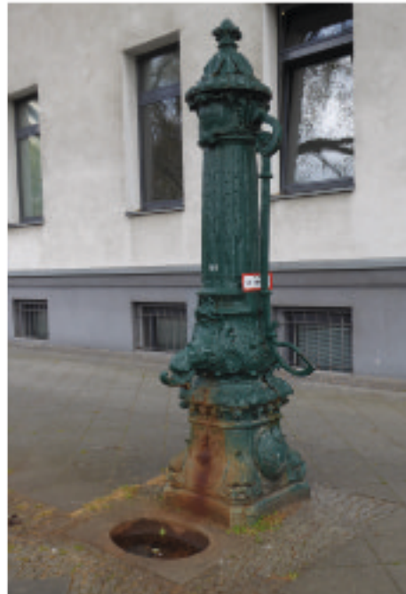
Historische Lauchhammerpumpe TYP I am Nollendorfplatz, Kleistraße 1 Foto eki
