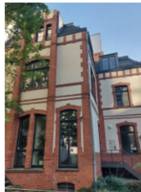
Backsteingebäudekomplex Innenhof, Am Karlsbad Nr. 11
