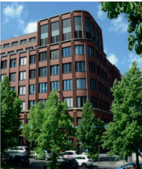
Haus 2 der Friedrich-Ebert-Stiftung am Landwehrkanal
