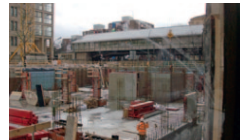
Blick in die Baugrube
