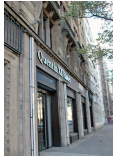
Fassade zur Potsdamer Straße Foto: Josef Lückerrath
