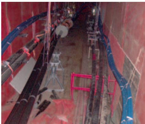
Blick in den Kontrollbunker Foto: Josef Lückerrath
