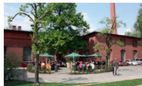
Foto: Die Pumpe
