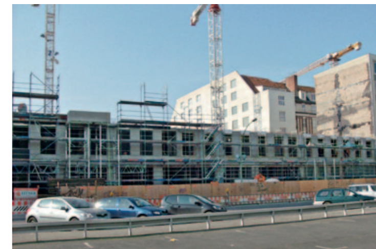
Bauarbeiten an der Genthiner Straße 40–46 Foto: J. Lückerrath
