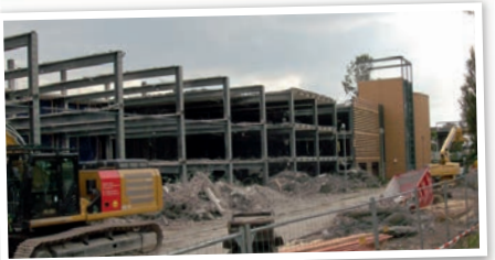
Stahlskelettbau, Abriss des südlichen Teils
