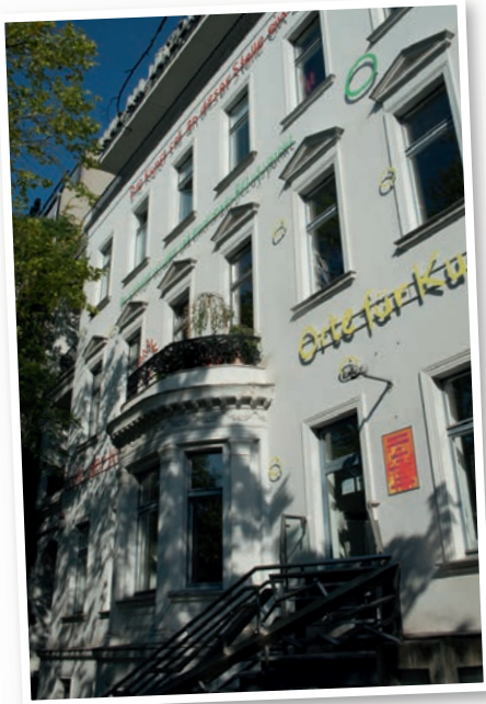
Eingang zum Haus am Lützowplatz (Foto: H. Wörmann)
