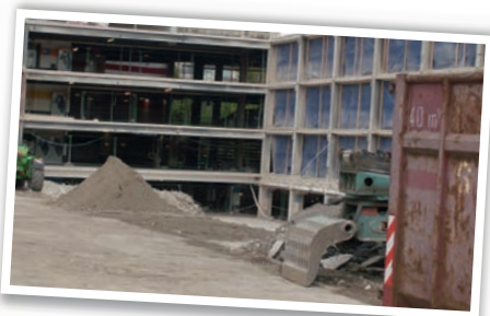
Der erste Teil zum Ufer hin ist weg, einschließlich Tiefgarage (Fotos: Josef Lückerrath)
