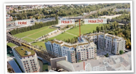
Bebauung Baufeld Süd von Westen gesehen (Fotos: Klarbau GmbH, Berlin)
