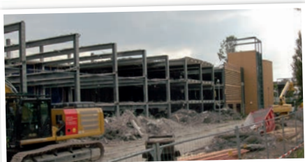
Stahlskelettbau, Abriss des südlichen Teils
